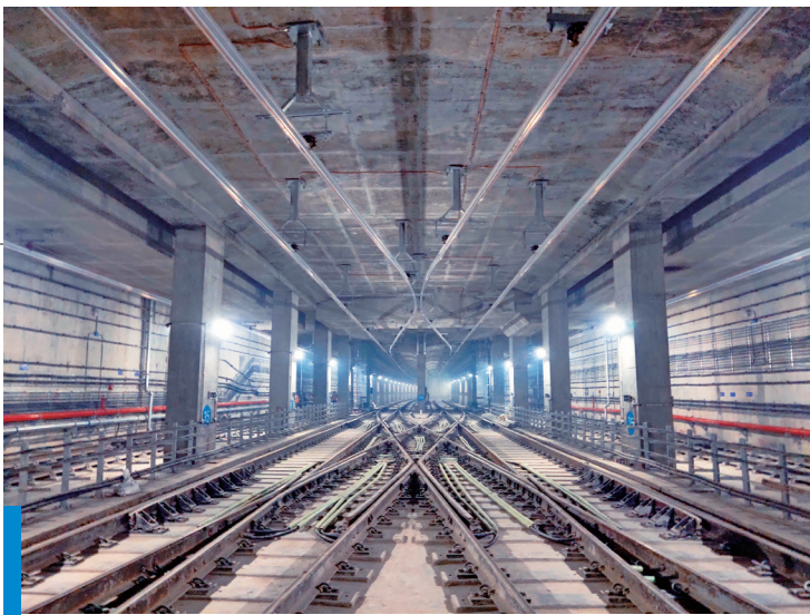
西部分公司成都地铁 6 号线项目
